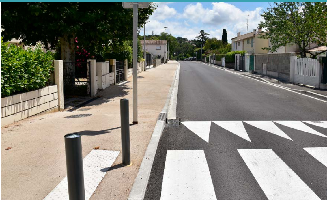
Les travaux de la rue du Patus se terminent fin juillet.
